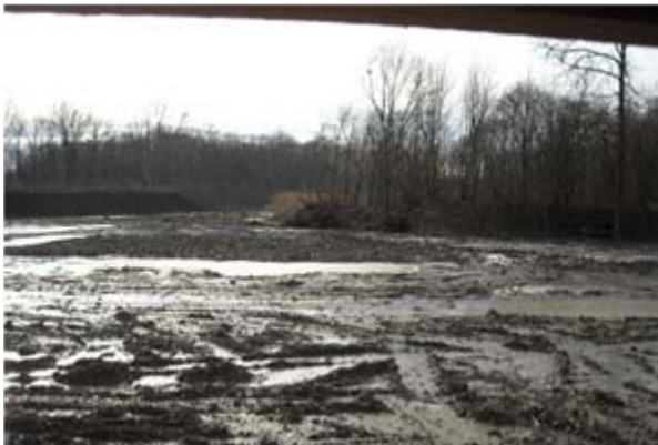
Site à la fin des travaux en 2009
