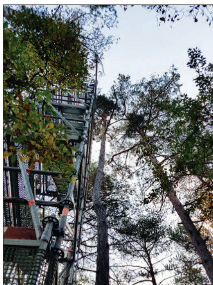
Photo 1 : Vu depuis le sol, les échafaudages permettent d'atteindre la hauteur de la canopée des arbres.
