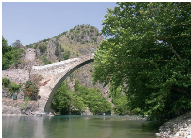
Station 1 : Pont sur l'Aoos.
