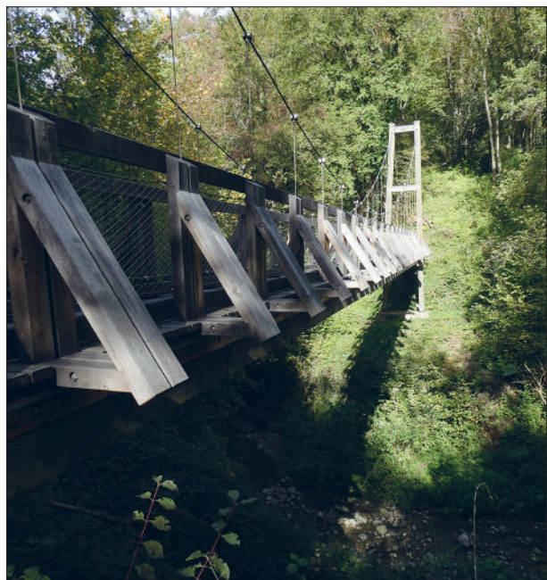
Fig. 5 : Passerelle pédestre au-dessus du Nant du Longet.
